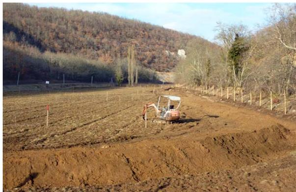
**Photo 4** : Un fossé d'évacuation des eaux pluviales entoure les côtés ouest et sud de la parcelle d'essai
